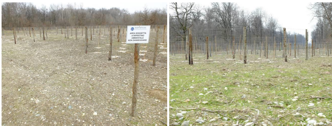
Figura 39: Cantiere Snam all’interno del Parco del Ticino, inerbito con fiorume
