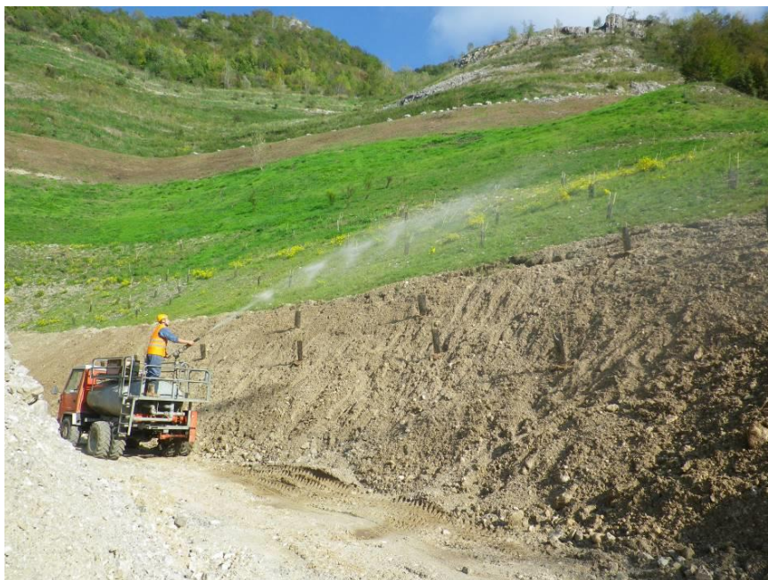
Figura 40: Inerbimento di scarpata in cava con idrosemina di fiorume
