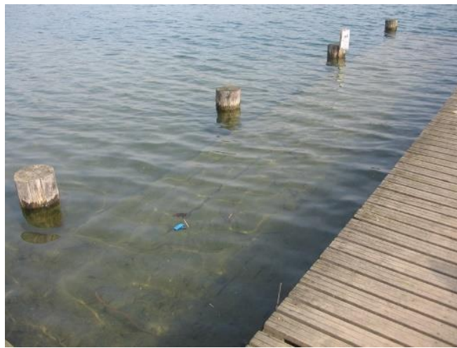
Figura 32: Struttura in legno esterna e appena sommersa che permette l'avvicinamento all'acqua in ragionevole sicurezza (Boscoincittà di Milano)
